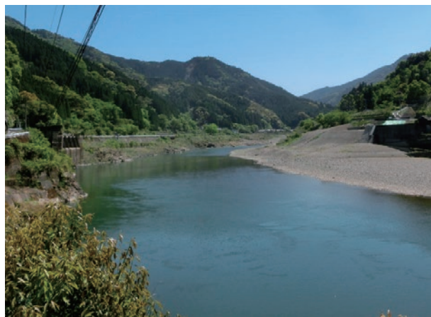
荒瀬ダム撤去後
