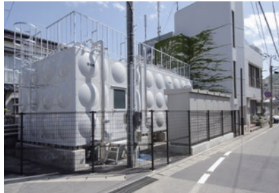
集中給湯設備外観
