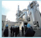
バイオマス発電所
