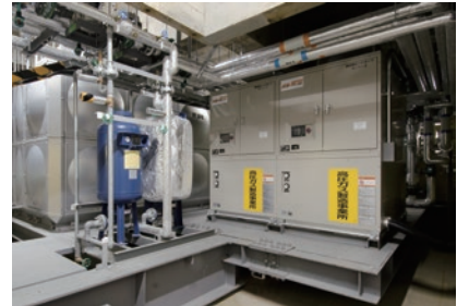
熱回収ヒートポンプ
