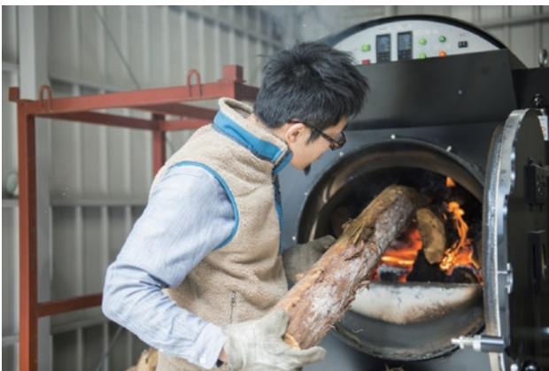
温泉施設の薪ボイラー
