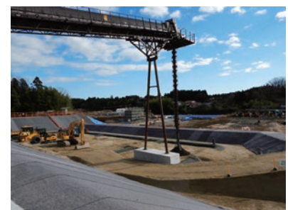
写真4-1-2 土壌貯蔵施設
