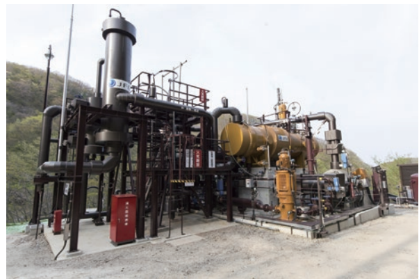
土湯温泉16号源泉バイナリー発電所
